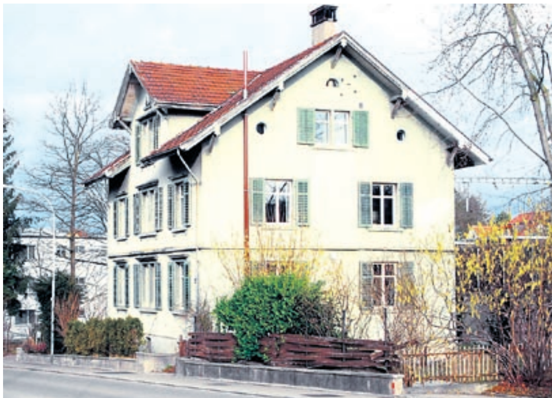
Die Liegenschaft an der Stationsstrasse 49, in welcher bald Asylsuchende leben werden, hat sich in ihrer äusseren Hülle kaum verändert. Innen wurde investiert. Bilder: mad
